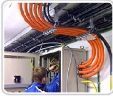
La separación entre el cableado de datos y el de energía eléctrica debe cumplir con los códigos de seguridad.
